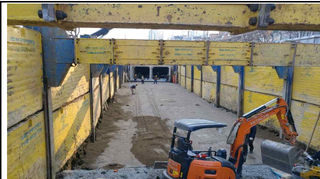
오류천 단면 확장 공사
