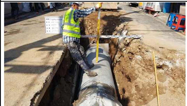
가리봉배수분구 하수관로 종합정비공사
