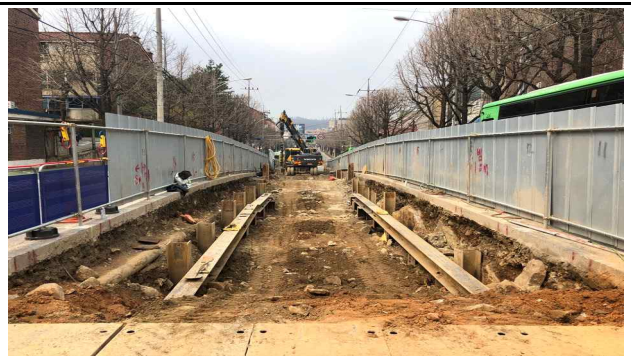
오류2배수분구 하수관로 종합정비공사
