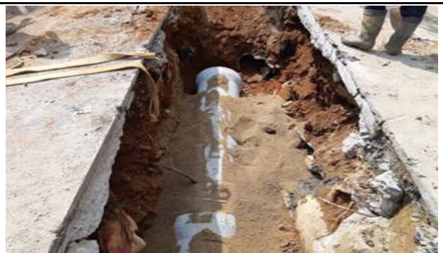
개봉배수분구 하수관로 종합정비공사
