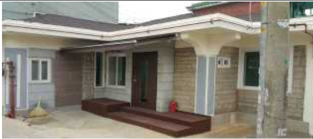
밤동산경로당 건물매입 및 리모델링(2015~2016)
